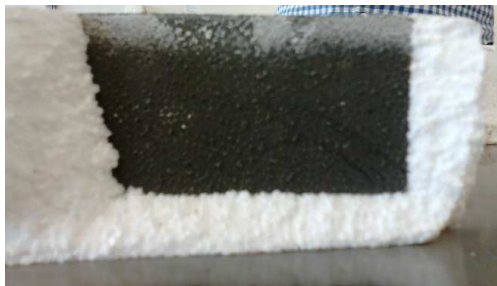
Rys. 3. Wysolenia na próbce geopolimeru Fig. 3. Salting on the geopolymer sample
