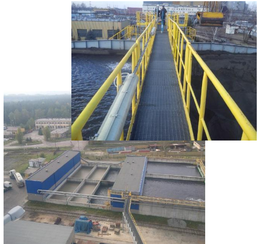
Instalacja klarowania wody używanej do hydrotransportu żużla w EI. Jaworzno III
