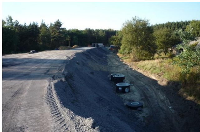
Budowa obwodnicy Chrzanowa
