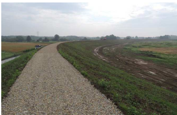
Rys. 3. Wał przeciwpowodziowy na Wiśle w okolicy Oświęcimia wznoszone z wykorzystaniem kruszyw z Zakładu Górniczego Janina [4]
